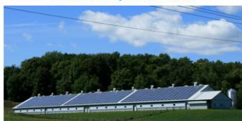
Photovoltaïque en toiture
